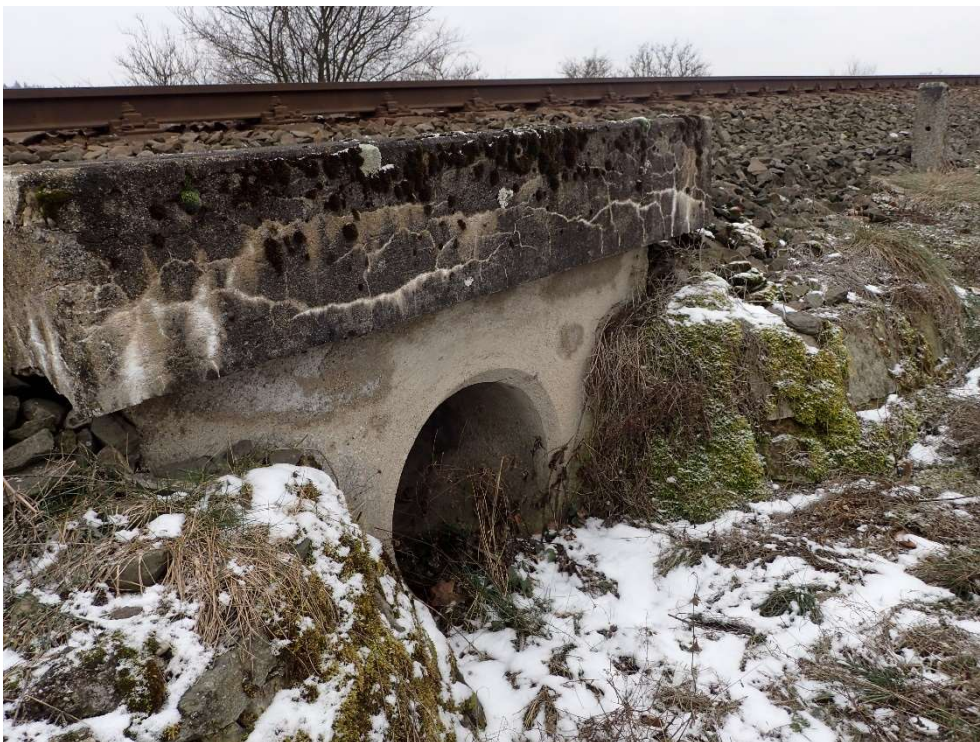
Foto 3: Degradovaný beton římsy včetně záteků na čele pod římsou
