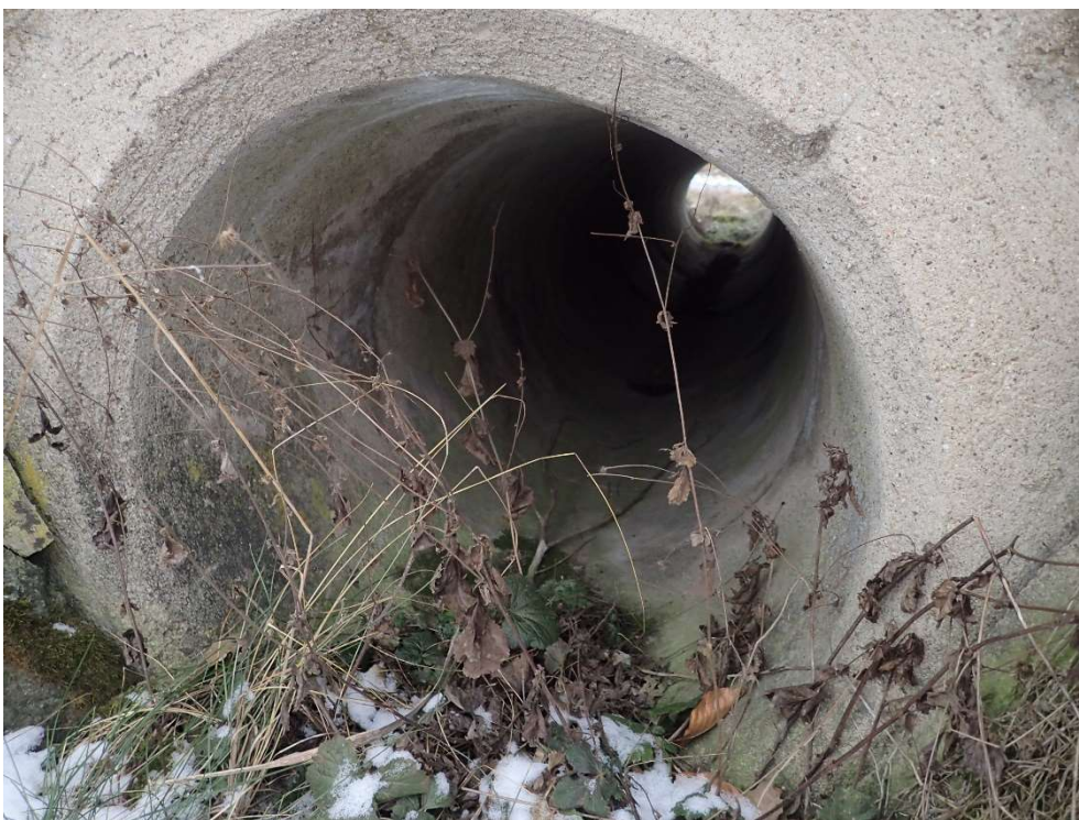
Foto 4: Znamky po zatékání ve spojích trub
