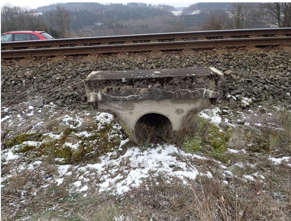
Foto 2: Pohled na vtok propustku
